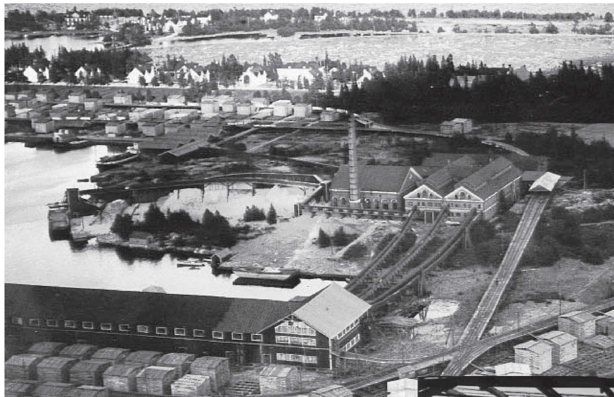
Flygfotografi över hyvelanläggningen
