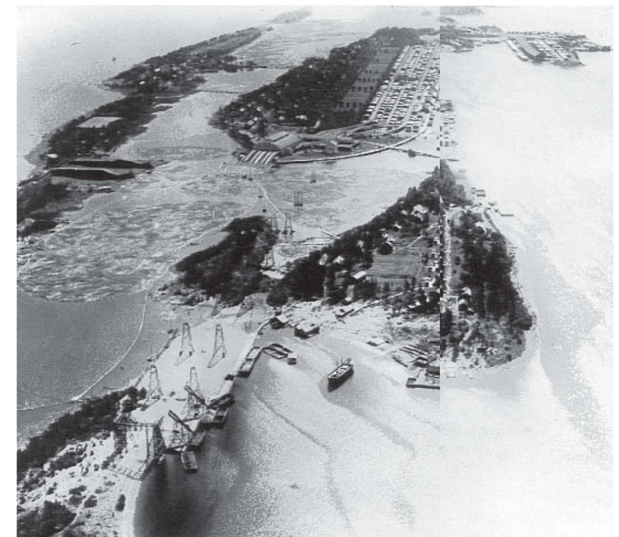
Flygfoto över slipen och spankajen
